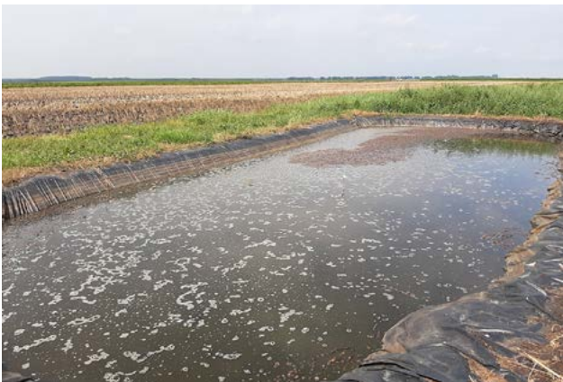
Bassins voor de inundatie van de tarragrond.
