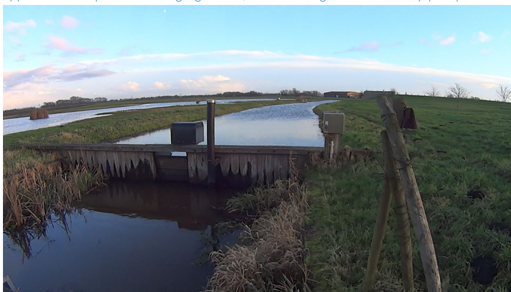
Figuur 22. Opgetrokken stuw ter hoogte van de hydrologische zone op 25 december 2020. Het bovenstroomse gebied watert hierdoor niet af op de vliegtuig-d-tocht.
