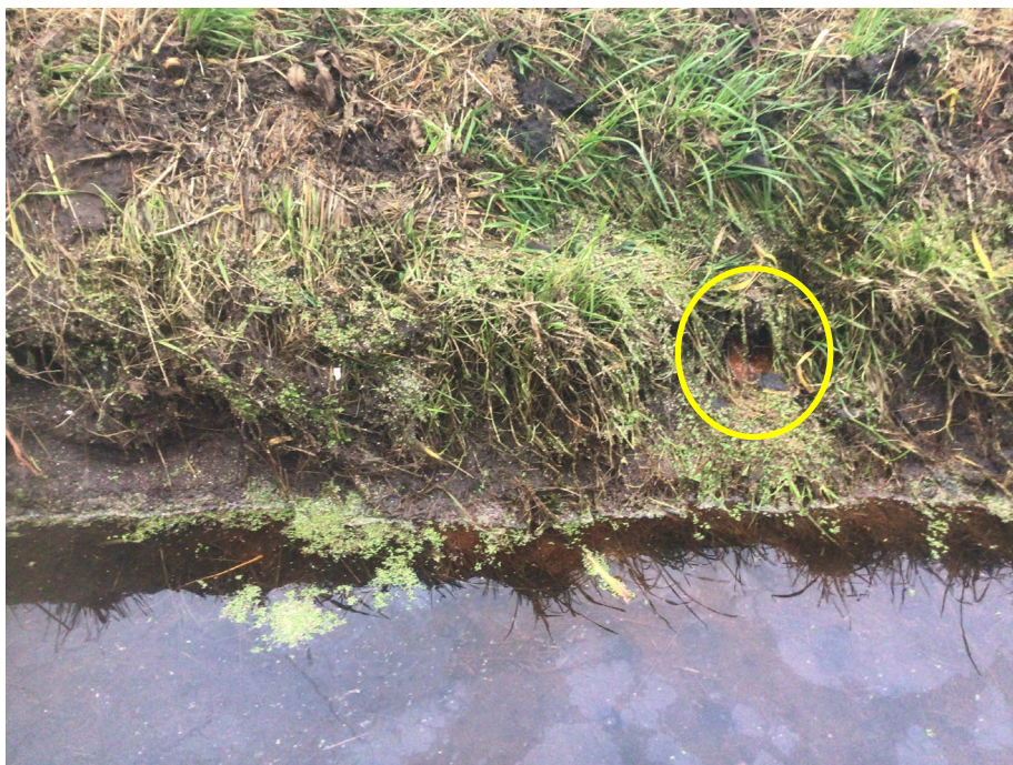
Figuur 28. Kroos en waterplanten tot boven de drainagebuis. Het water bevat een oliefilm dat duidt op aanwezigheid van kwel.
